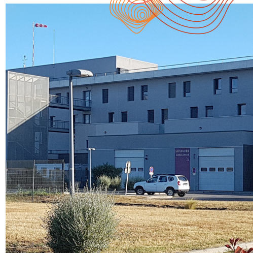
Entrée avant travaux
